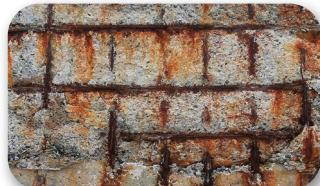
metallica da depositi di sali, ruggine distaccata, grassi e sporcizia. Con il trattamento il film di ruggine formatosi sulla superficie del ferro verrà trasformato in magnetite, una sostanza inerte che blocca il processo di ossidazione del ferro e dei suoi derivati.
